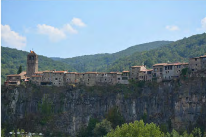
Il borgo di Castellfollit de la Roca (foto dell'autore)
